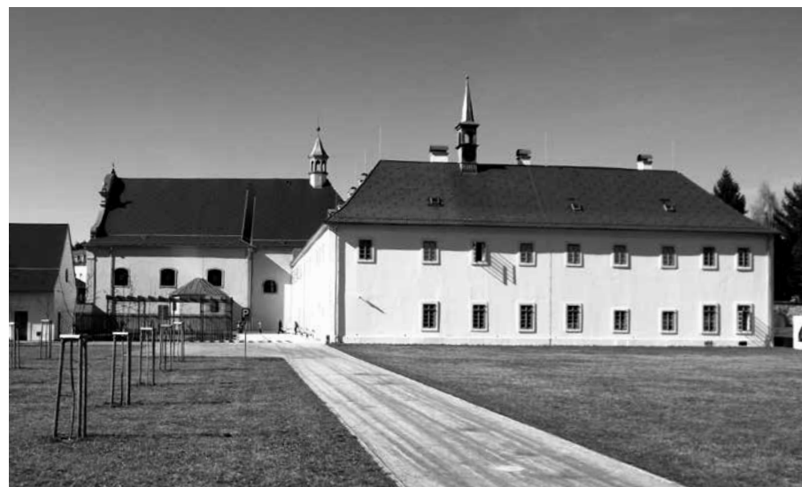
OPRAVA KONVENTU FRANTIŠKÁNSKÉHO KLÁŠTERA V HOSTINNÉM BYLA FINANCOVÁNA Z ROP SEVEROVÝCHOD.
