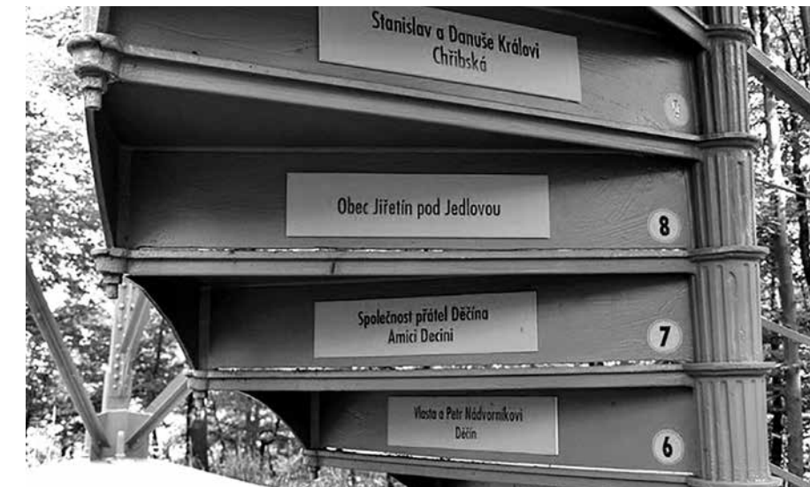
ZÁJEMCI PODPOŘILI OPRAVU ROZHLEDNY KOUPI JEDNOTLIVÝCH SCHODŮ.
