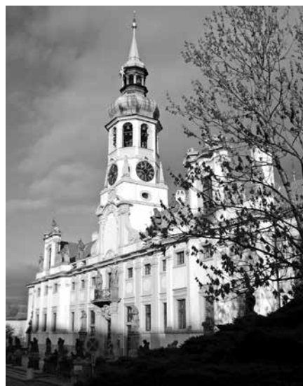
DRENÁŽE A ODSOLENÍ KAMENNÉHO SOKLU LORETY BYLY FINANCOVÁNY Z GRANTU HL. M. PRAHY.
