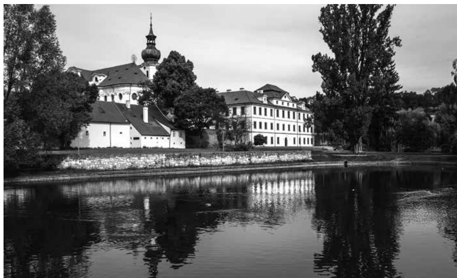
BŘEVNOVSKÝ KLÁŠTER ZÍSKAL V ROCE 2015 GRANT NA OPRAVU KROVU PRELATURY A STROPŮ.
