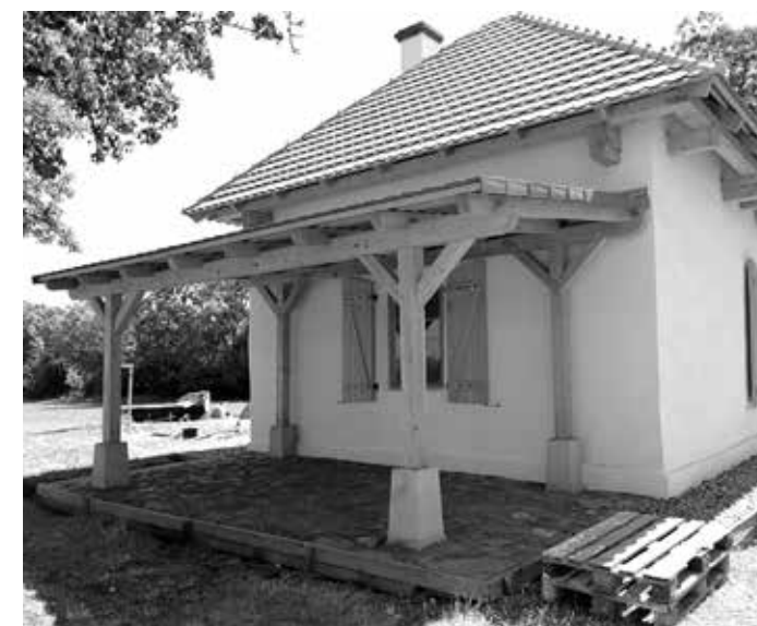
ZÁKOLANY-BUDEČ, HROBNICKÝ DOMEK PO OPRAVĚ
