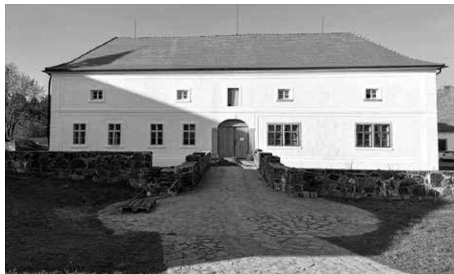
PAKOMĚŘICKÝ ZÁMEK PO OPRAVĚ
