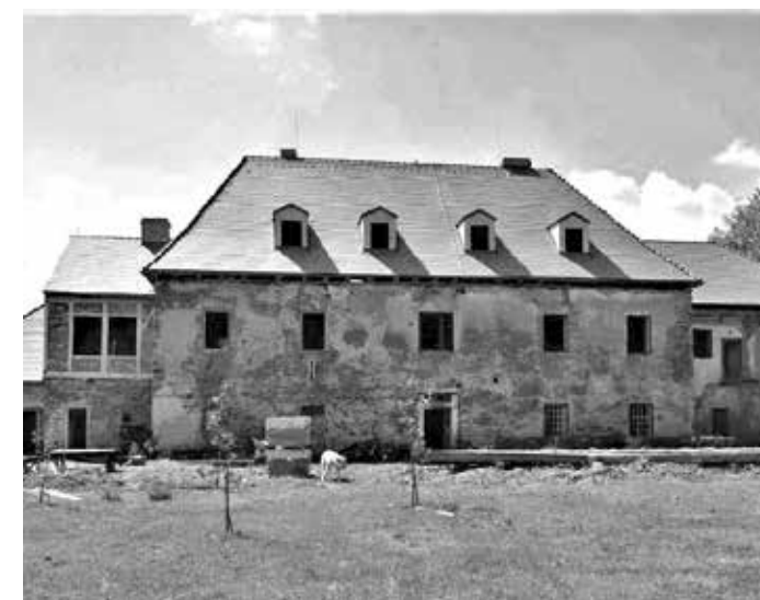
OBJEKT PO OBNOVĚ
