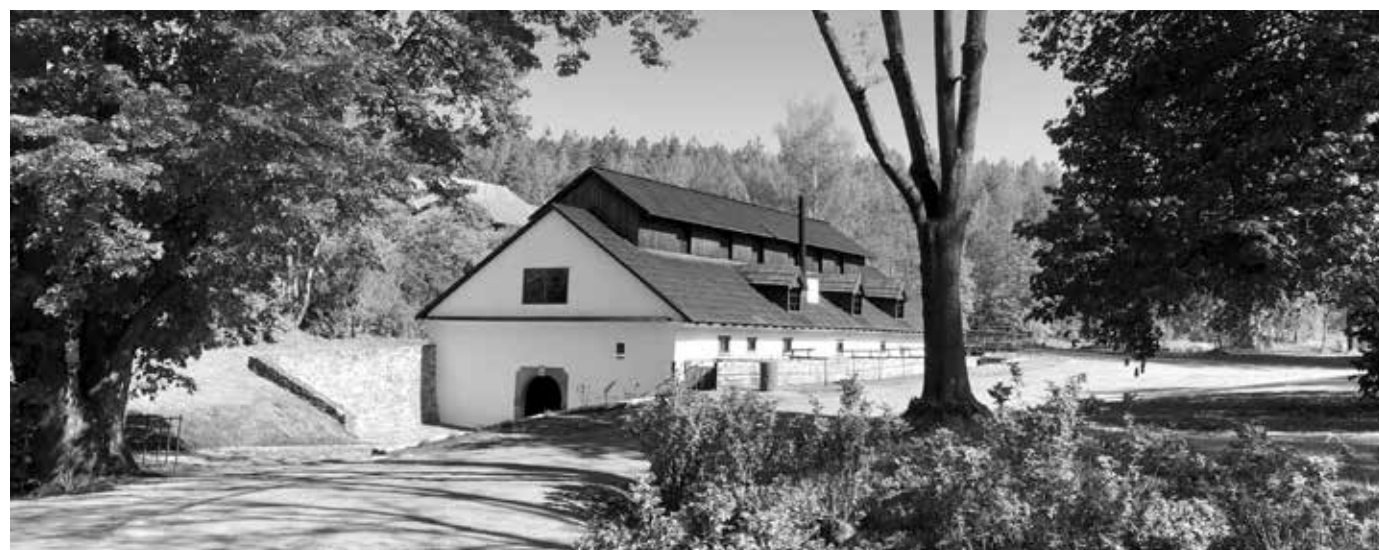
CELKOVÝ POHLED NA OBNOVENÝ HAMR V DOBŘÍVĚ U ROKYCAN S UPRAVENÝMI OKOLNÍMI PLOCHAMI
