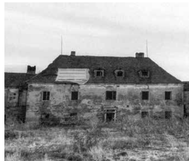
ŽÁKÝ – ZÁMEK PŘED OPRAVOU
