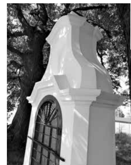
POHLED NA OPRAVENOU KAPLI V MAŘATICÍCH
