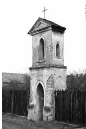
ZVONIČKA VE VESELÍ U CHCEBUZE PŘED REKONSTRUKCÍ
