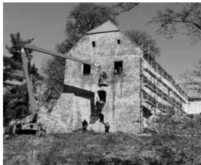
POHLED NA PRŮBĚH PRACÍ PŘI OBNOVĚ SÝPKY VE HVOŽDANECH
