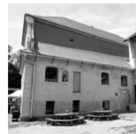
BOČNÍ POHLED NA OBNOVENOU MLÝNICE
