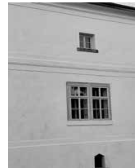
OBNOVENÁ FASÁDA ZÁMKU V PAKOMĚŘICÍCH
