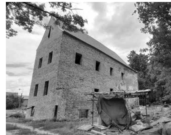
V ROCE 2022 PROBÍHÁ REALIZACE II. ETAPY OBNOVY.
