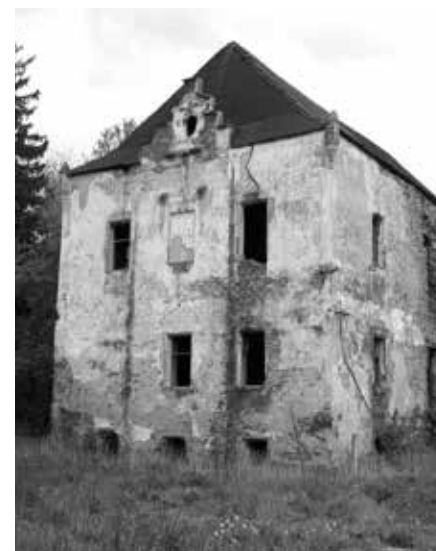
STAV ZÁMKU PŘED REKONSTRUKCÍ
