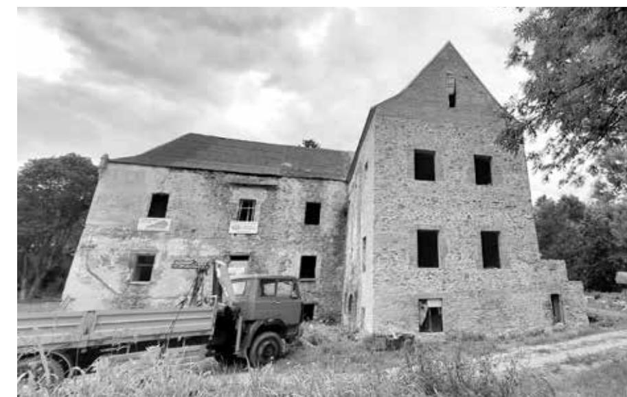
STAV ZÁMKU PO REALIZACI I. ETAPY OBNOVY
