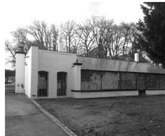
ORANŽERIE PO REKONSTRUKCI
