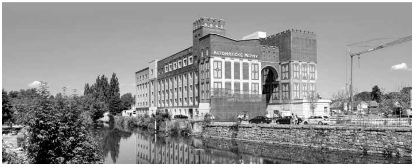
ČERVEN 2023, GG PŘED DOKONČENÍM OBNOVY
