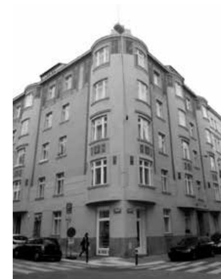
ULIČNÍ FASÁDA, Č.P. 327, MALÍŘSKÁ 9, PRAHA 7, K.Ú. BUBENEČ
