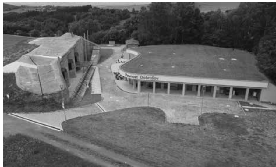
PROVOZNÍ BUDOVA S EXPOZICÍ A DĚLOSTŘELECKÝ SRUB ZELENÝ
