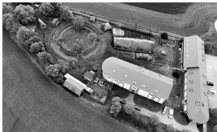
AREÁL ARCHEOPARKU VŠESTARY S PŘÍSTAVĚNOU BUDOVOU PRAVO
