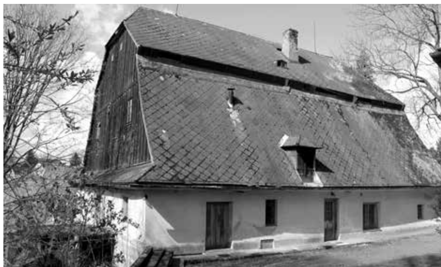
UNIKÁTNÍ PAMÁTKOVĚ CHRÁNĚNÝ OBJEKT VODNÍHO MLÝNA V PETROVICÍCH POCHÁZÍ Z PRVNÍ POLOVINY 15. STOLETÍ.
