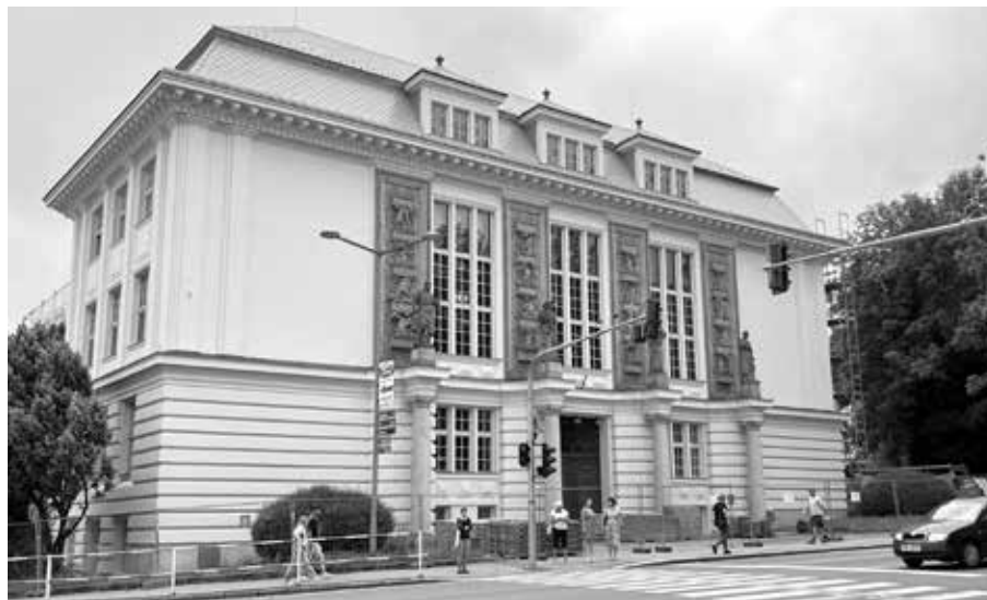
HLAVNÍ PRŮČELÍ BUDOVY PO REKONSTRUKCI
