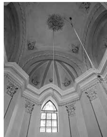
INTERIÉR KAPLE ANDĚLŮ STRÁŽNÝCH VE VOLYNĚ
