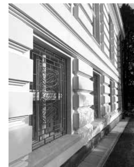
ZDOBNÉ KOVOVÉ MŘÍŽE JAKOŽTO CHARAKTERISTICKÝ PRVEK BAUEROVÝCH STAVEB
