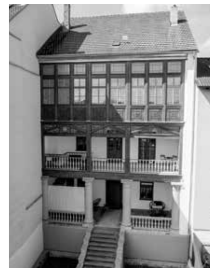
STRAKONICE, VELKÉ NÁMĚSTÍ 149, ZADNÍ FASÁDA PO REKONSTRUKCI
