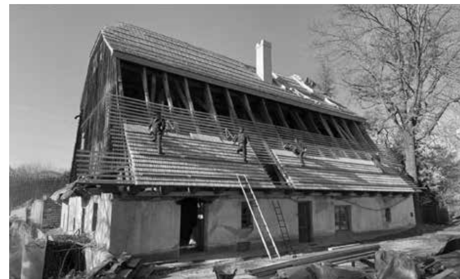
REKONSTRUKCE AREÁLU ZAČALA STŘECHOU HLAVNÍ BUDOVY.
