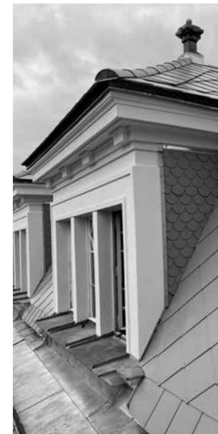
JEDEN ZE 3 VIKÝŘŮ MANSARDOVÉ STŘECHY S ŘADOU NAVRÁCENÝCH ŘEMESLNÝCH DETAILŮ
