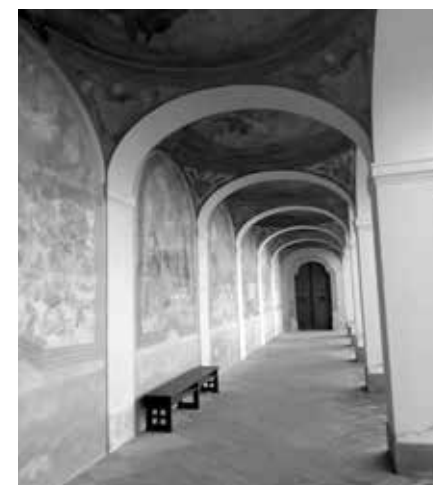
RESTAUROVÁNÍ AMBITŮ V POUTNÍM KOSTELE PANNY MARIE VÍTEZNÉ NA BÍLÉ HOŘE, KARLOVARSKÁ, PRAHA 17, K.Ú. ŘEPY
